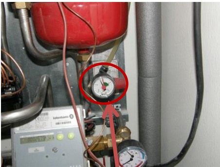
Manometer og sikkerhedsventil
